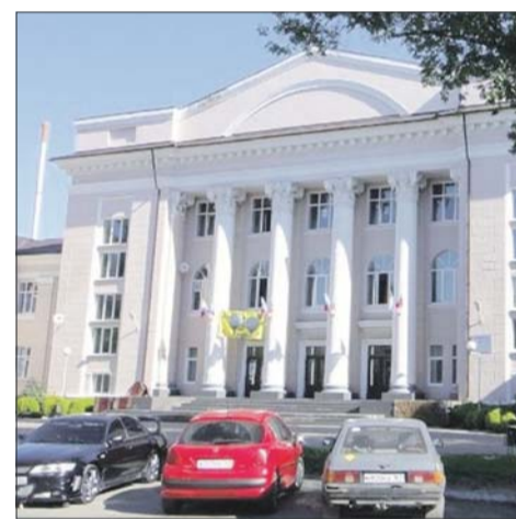
Часть денег на ремонт соберут жители.
