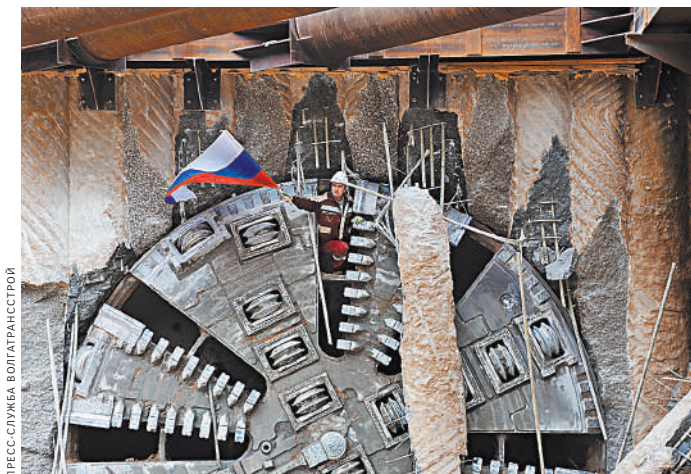
Исторический момент — проходка тоннеля завершена.
