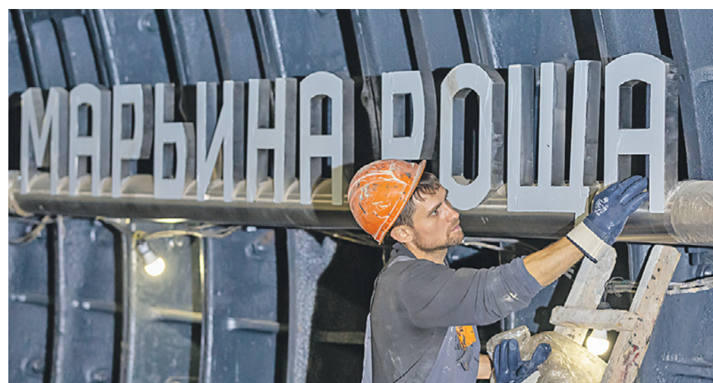
12 августа 2022 года. Рабочий Иван Морозов проверяет надежность крепления названия станции «Марьино Рошча», строящейся на Большой кольцевой линии метро
