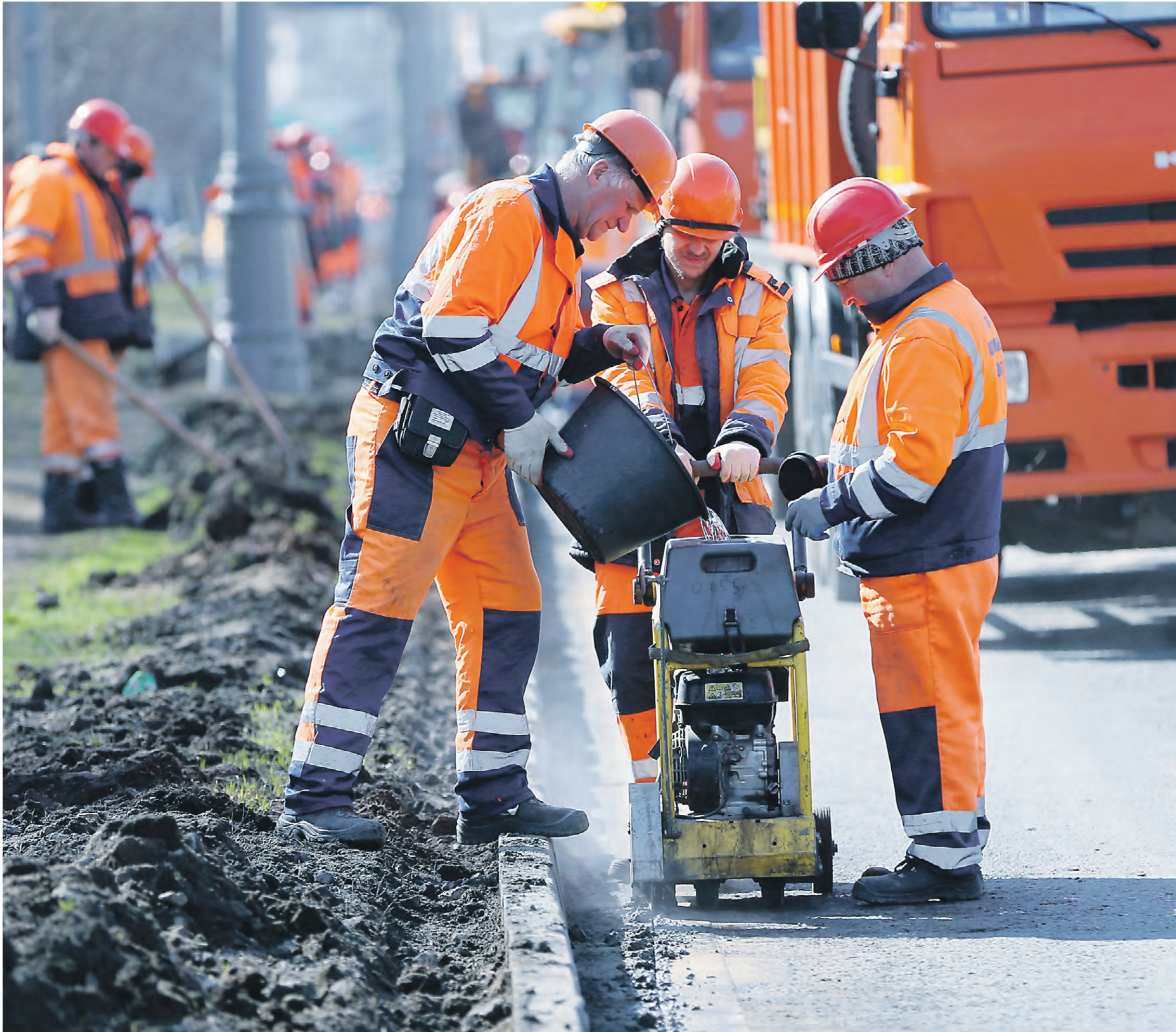
11 апреля. Сотрудники ГБУ «Автомобильные дороги» во время работ по замене бордюрного камня на Дмитровском шоссе в столице. Сегодня в городе 80 масштабных проектов по благоустройству дорог и дворов вдоль них
